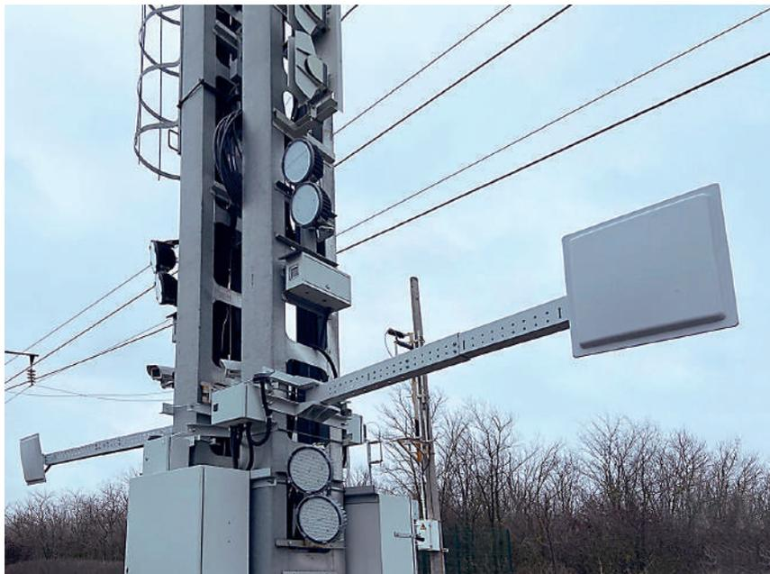
Рис. 5. Система СИБУК СПСГ в составе ППСС на подъезде к станции Батайск Северо-Кавказской железной дороги
