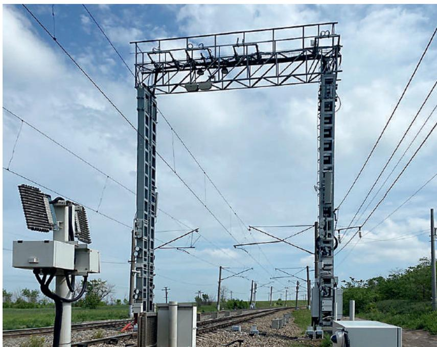
Рис 1. Комплекс ППСС на подъезде к станции Батайск Северо-Кавказской железной дороги
