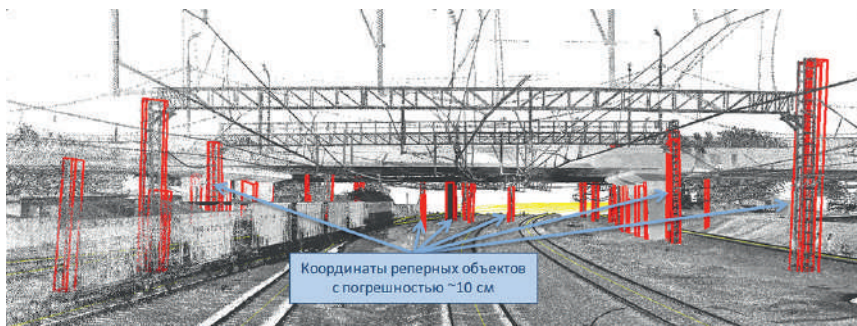
Рис. 3. Реперные объекты на трехмерном изображении лидарного сканирования
