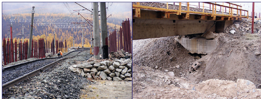
Рис. 2. Вид деформирующегося участка железнодорожного пути и искусственных сооружений на разъезде Казанкан Восточно-Сибирской железной дороги (686 км): слева – осадка земляного полотна, справа – просадка грунта в основании опоры моста (фотографии при проведении обследований в сентябре 2003 г. сотрудниками лаборатории инженерной геологии и геоэкологии Института земной коры СО РАН доктором геолого-мин. наук, проф. Тржцинским Ю.Б., кандидатом геолого-мин. наук Лапердным В.К., кандидатом геолого-мин. наук Козыревой Е.А.)
