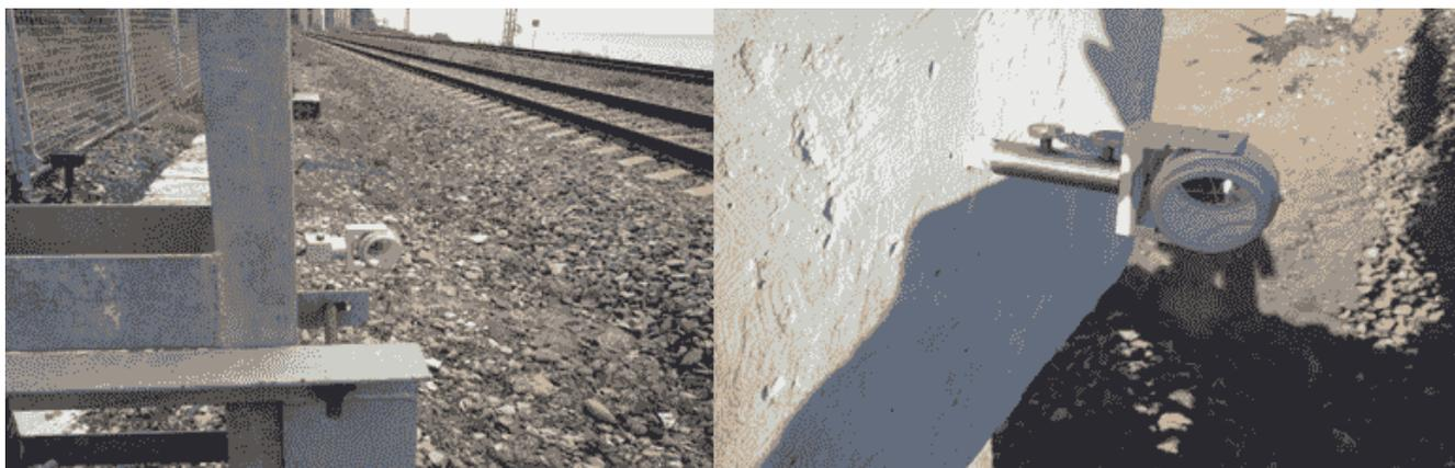
**Рис. 2.** Установка отражателя на репер с фиксацией:
