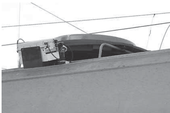
Рис.4. Станция спутниковой связи RaySat SR2000.
